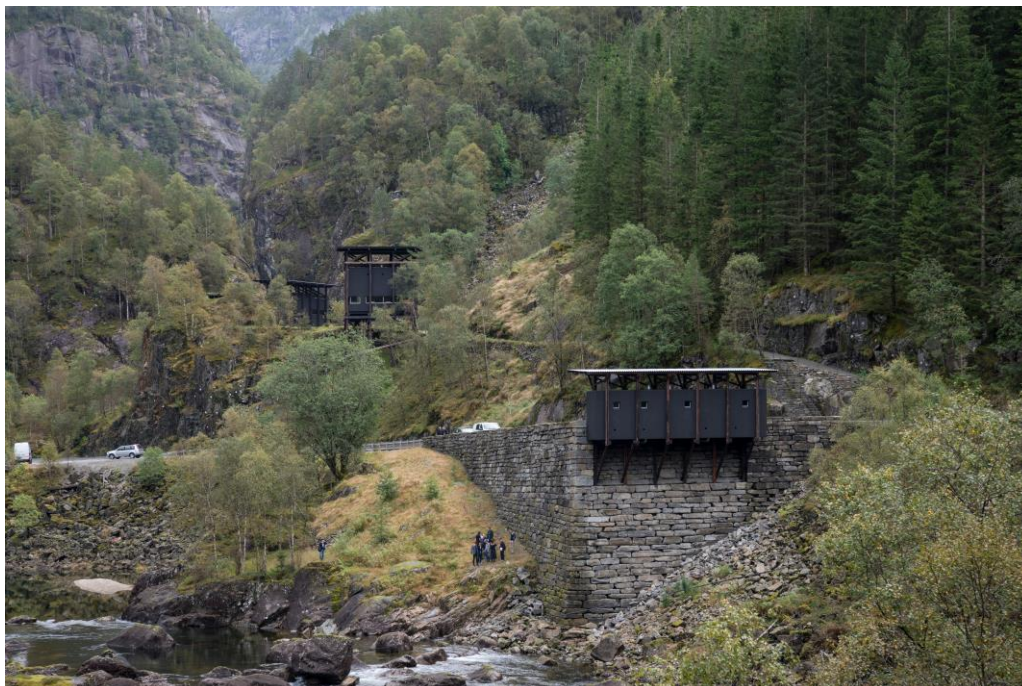
Figur 15: Nasjonal turistveg Ryfylke slynger seg forbi attraksjonen Allmannajuvet som består av et galleri, gruvekafe, toalett, parkering, stier og trapper. Toalettet, kafeen og museet er vist på bildet under © Per Berntsen.
